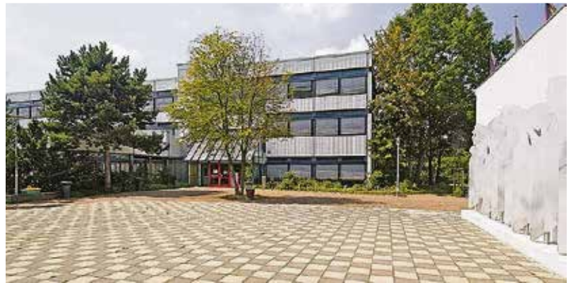
Die Ausschreibung für die Sanierung des VHS-Daches blieb ohne Erfolg. Die Arbeiten werden nun erneut ausgeschrieben. ARCHIV: SEEGER
